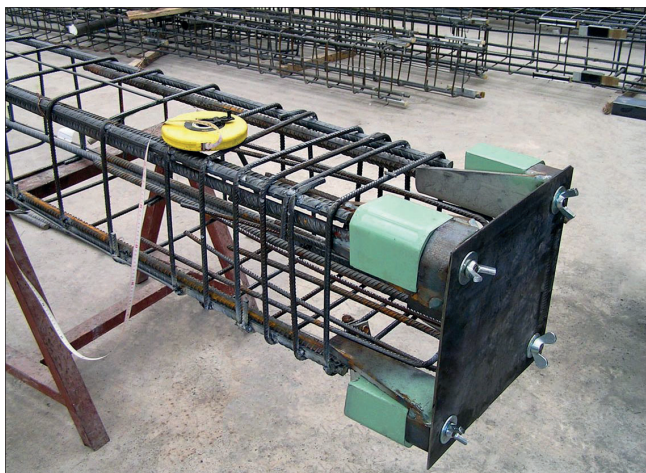
Башмаки колонн НРКМ® до и после заливки бетона
