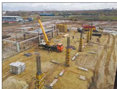
Рис. 4. Монтаж монолитных колонн на строительной площадке Fig. 4. Installation of monolithic columns on the construction site
