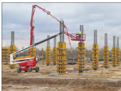
Рис. 4. Монтаж монолитных колонн на строительной площадке Fig. 4. Installation of monolithic columns on the construction site
