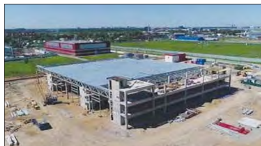
Рис. 5. Процесс возведения здания Fig. 5. The process of building construction
